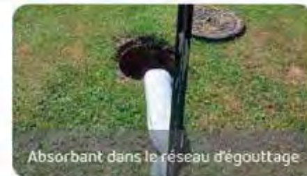
Lingettes et barrage absorbants à la sortie du DO
