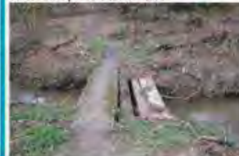
Passerelles placées trop basses
