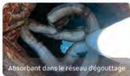
Lingettes et barrage absorbants à la sortie du DO
