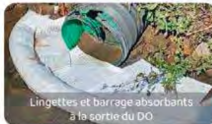
Absorbant dans le réseau d'égouttage
