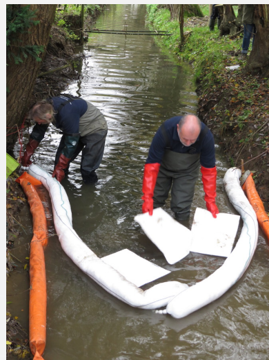
mise en oeuvre des absorbants
