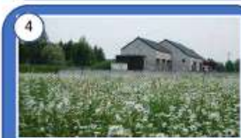
Station d'épuration de Jodoigne INBW
