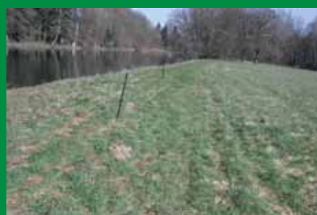
En haut : verse de piquets placés trop près de la crête de berge (sur la Ligne à Tongrinne) En bas : piquets placés à bonne distance de la crête de berge (sur la Semois) - Photos Cellule Rives-FUSAGx
