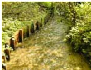
**Le tunage (clayonnage)** : les clayons sont des lamelles de bois tressés ou petites planches retenues par des piquets pour soutenir des terres et les empêcher de s'ébouler.
