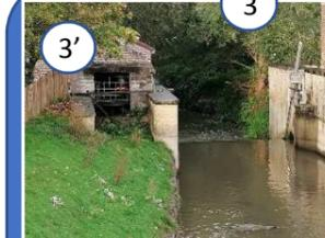
La **vanne** du moulin (3) est laissée en place dans le but de réguler le niveau d'eau lors de crues et aussi en période de sécheresse. Elle doit rester le plus souvent possible abaissée pour le passage des poissons et pour limiter l'envasement en amont. Elle reste, en l'état actuel, encore un obstacle. Des aménagements sont à l'étude pour faciliter la remontée des poissons.
